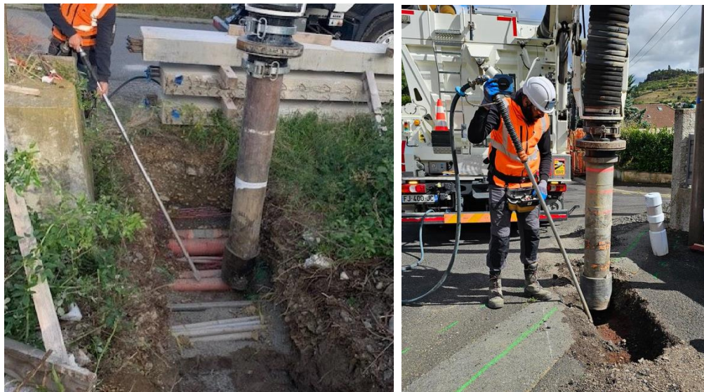
Délitement avec lance à air et aspiration sans contact dans la zone de précaution.
